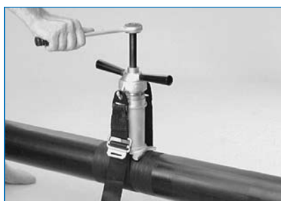
Рис. 11. Прорезание отверстия на месте сквозного повреждения ПЭ трубы для дальнейшего ремонта.
