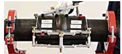
Рис. 1. Установка ремонтной разъемной муфты с ЗН на полиэтиленовый трубопровод Ø 110 мм.
