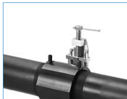
Рис. 16. Установка усилительной муфты Georg Fischer на ремонтируемом участке ПЭ трубопровода.
